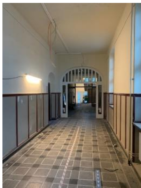
Neue Türen im Flur
